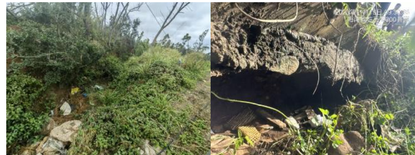
桥梁锥坡附近路基冲毁照片
