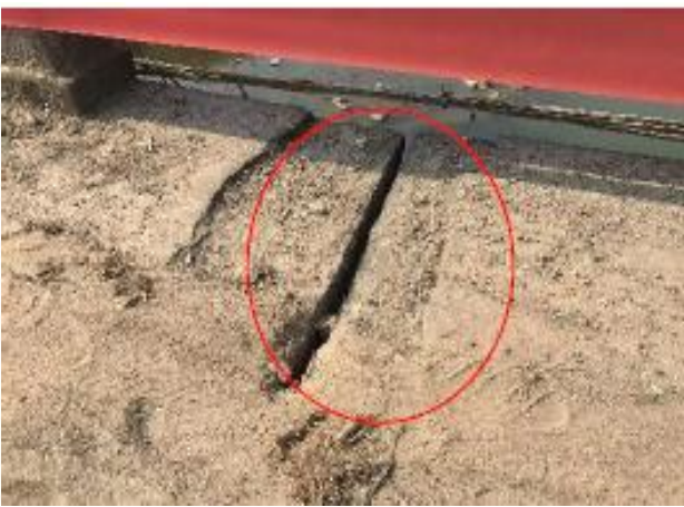
左侧人行道板多处破损
