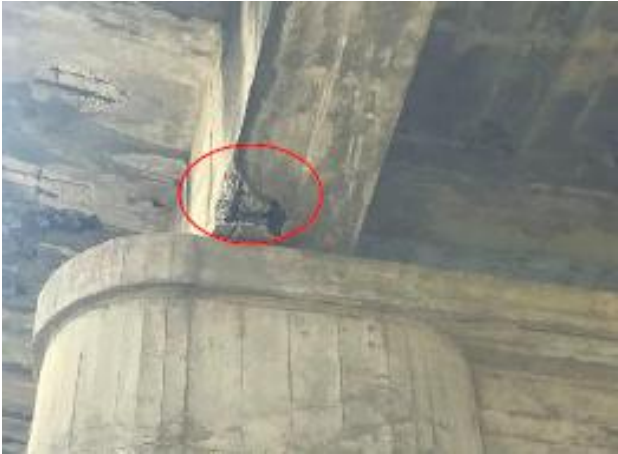
4-3#T 梁底面破损露筋
