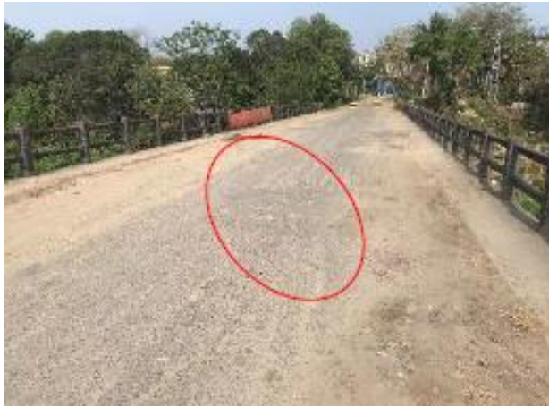
桥面铺装大面积磨光露骨
